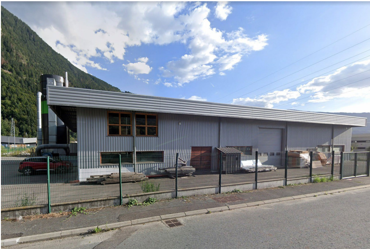
Bâtiment PME situé rue des Egratz
