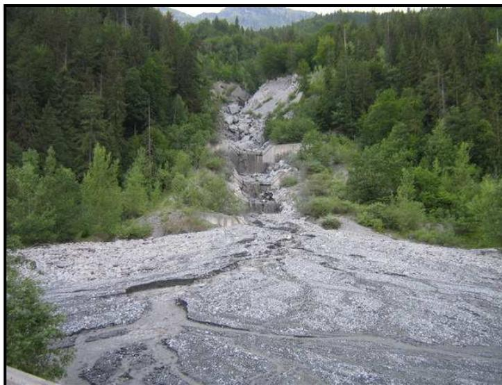
**Photo 3** : Engravement de la plage de dépôt sur le Nant Bordon,
