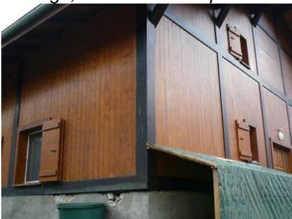
*Doublage de la grange par un bardage extérieur banalisant*
