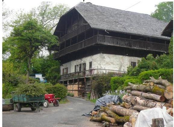
*Maison passerande Champlan. Variante, 2 niveaux maçonnés (logis au dessus des animaux ou d'une cave pour le vin ?), étage et comble en bois, toit à deux pans avec fausse croupe dite « Allemande ». Ici couverture en ardoises.*
