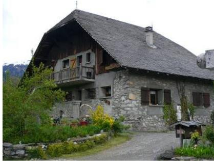
Décroustage de l'enduit pour « pierres apparentes » mais qui laisse apparaître les transformations d'ouvertures réalisées en ciment
