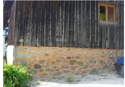
Décroustage de l'enduit et rejointoyage des pierres avec un mortier contrastant
