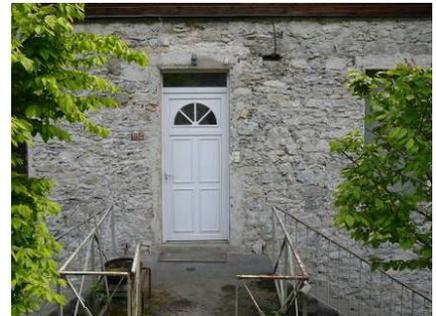
Mur décrousté, porte de style anglo-saxon qui n'est pas adaptée à l'ouverture d'origine
