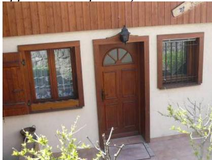
Enduit projeté et dressé (ce qu'on fait sur les maisons neuves), bardage clair en planches étroites, cadres en bois autour des ouvertures, pose de menuiseries banalisantes (ici porte de style anglo-saxon !)
