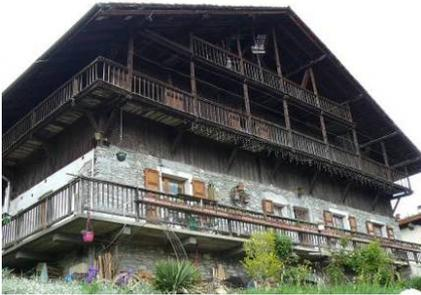
Décroustage de l'enduit pour « pierres apparentes » ; Les pierres ne sont pas faites pour être vues, le mur est fragilisé, il perd en isolation.
