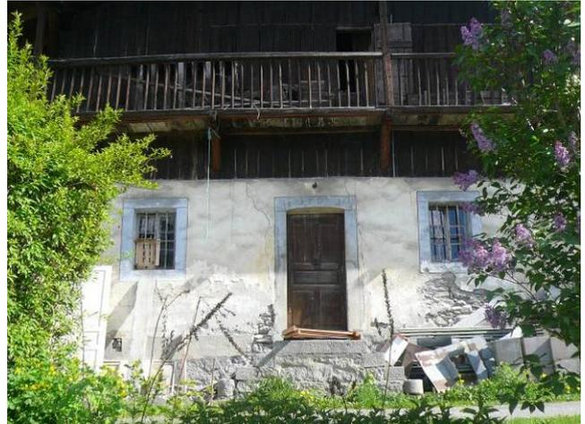
L'enduit pouvait aussi être traité plus finement et coloré avec décor peint pour les encadrements d'ouvertures ; fenêtres doublées d'un barraudage métallique, il n'y a pas de volets. Les Plagnes.
