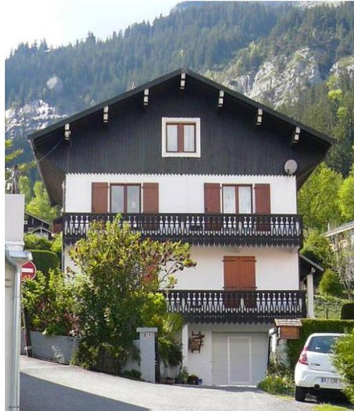
*Balcons : introduction de palines chantournées dont le dessin ne correspond pas à la région. Perte des couleurs vives d'origine. Changement des menuiseries : perte de la partition des châssis. Palines chantournées pour le balcon*
