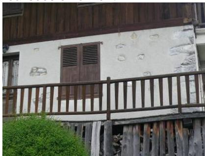
Les enduits au ciment, les faux pierre vue (enduit en surépaisseur, creusé à posteriori pour faire apparaître les pierres)
