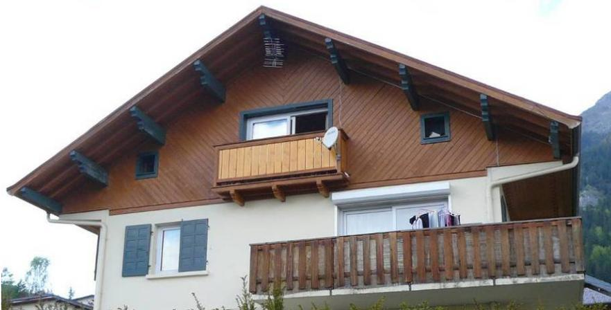
*Balcon rendu opaque, changement des menuiseries (ici coulissant), Caisson de volet roulant en saillie.*
