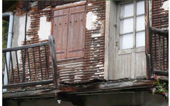
*Aménagement ancien d'une grange, Cran. L'enduit dégradé laisse apparaître un lattis qui recouvre une structure bois remplie d'une maçonnerie légère.*
