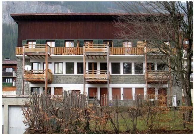
*Rajouts de colonnes de balcons superposés qui perturbent les lignes horizontales de la composition de la façade, ensemble des garde-corps en bois clair en contradiction avec le choix initial (bois sombre), alternance de lisses horizontales et de barreaudage vertical....*
