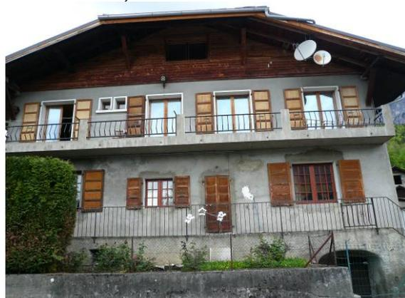
*Maison ancienne transformée, à l'exception du comble. Réhabilitation années 60 (volets à cadre bicolores, cadre blanc saillant, balcon béton avec garde-corps métallique) et postérieur (retour au ton bois, menuiseries standardisées) Cran*
