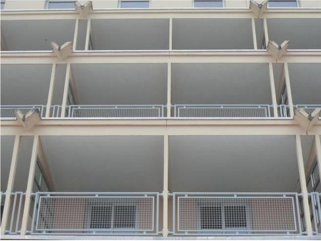
*Détails des garde-corps et des écoulements*
