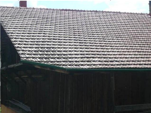
Toiture en tuiles mécaniques plates à côte centrale. Le modèle losangé est très fréquent.
