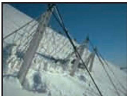
Filets paravalanches retenant la neige dans une zone de départ d'avalanche (cliché : F. Valla, Cemagref)
