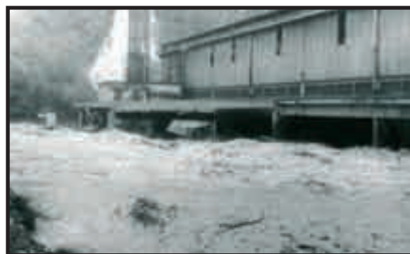
Débordement des eaux de crue en rive droite de l'Arve sur le site de l'usine de Chedde le 22 septembre 1968. Les eaux ont envahi les bâtiments de l'usine et inondé la localité de Chedde
